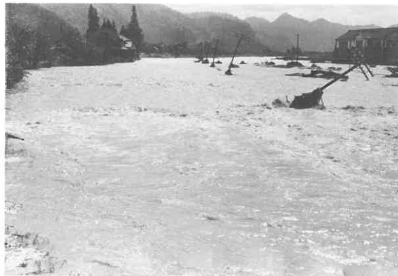
堤防決壊し、濁流と化した校舎周辺
