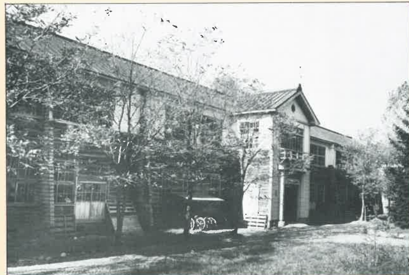
③ 改築前の南会津高校(昭和48年)
