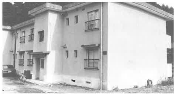
県職員住宅新築 (昭和46)
