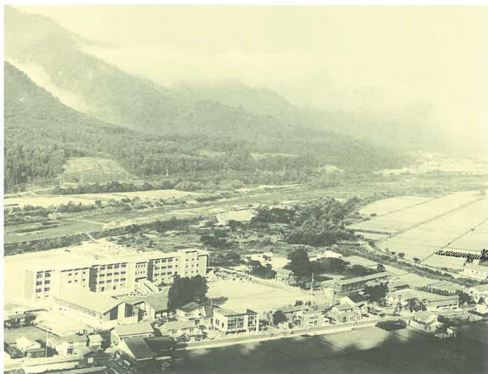
◀新校舎となった南会津高校・新体育館は工事中(昭和55年)
