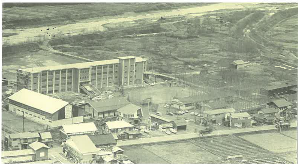
改築工事が進む校舎▶ (昭和53年)
