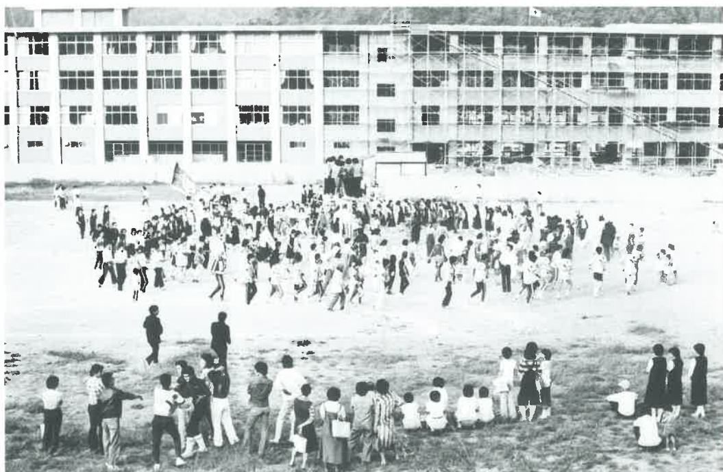
第6回南高祭 新校舎は改築工事中(昭53)
